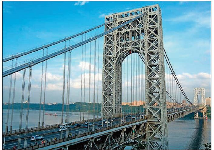
del ponte si prevedeva di racchiudere la struttura metallica in cemento armato rivestito da lastre di granito, ma il risparmio dovuto alla Grande Depressione portò a rinunciare al progetto. Così le torri in metallo esposto, con i loro distintivi e innumerevoli raccordi metallici a croce di sant'Andrea, sono diventate una delle caratteristiche distintive del ponte.
